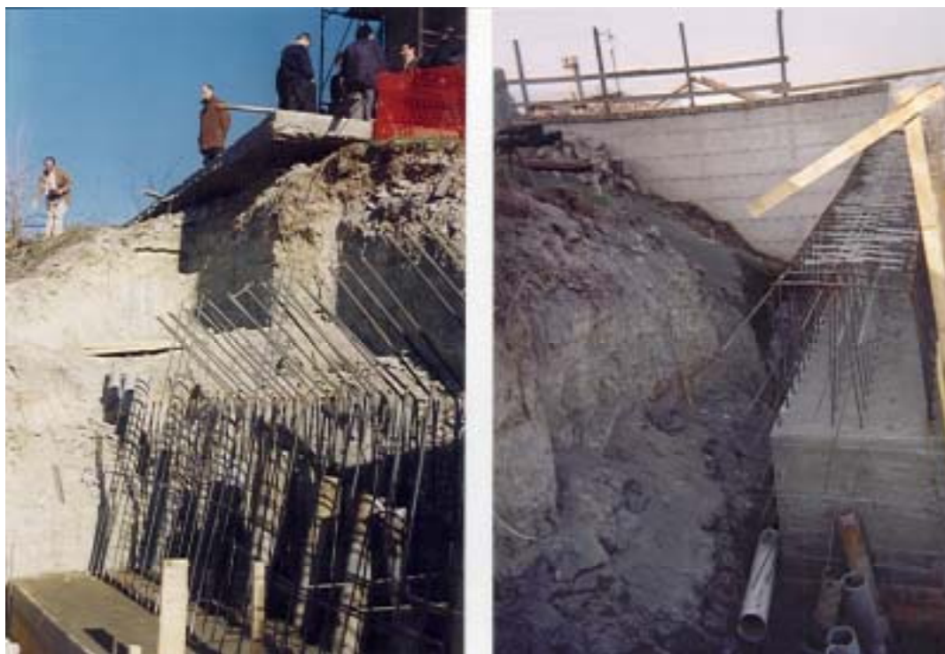
Opere di stabilizzazione di valle
