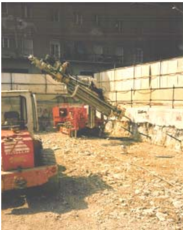
Fotografia 2: Realizzazione tiranti
