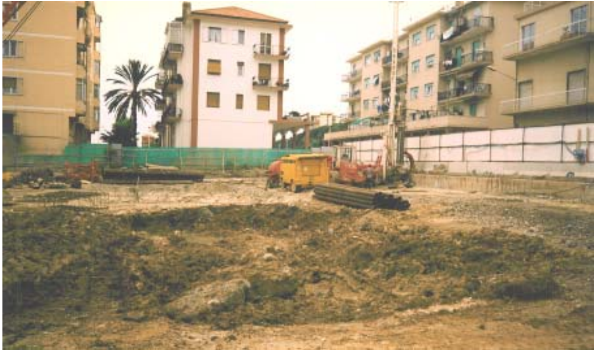
Fotografia 1: Realizzazione micropali
